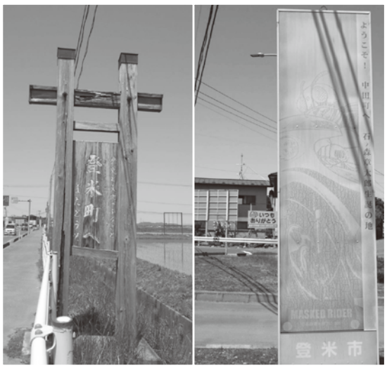
日焼け、風化により劣化が進む看板
