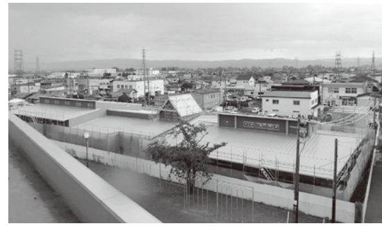
現在建設中の迫児童館（31年4月開園予定）
