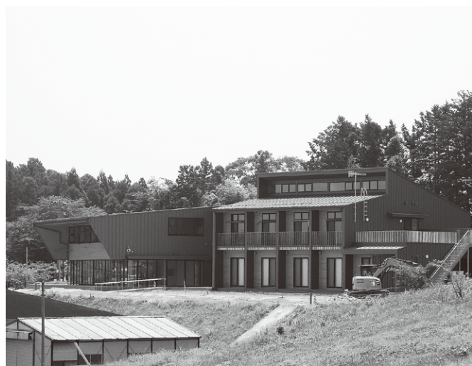
完成間近の長沼ボート場クラブハウス
