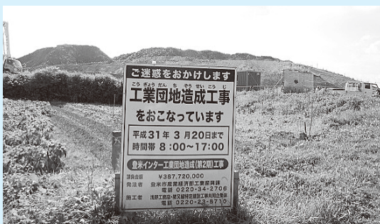
造成が進む（仮称）登米インター工業団地
