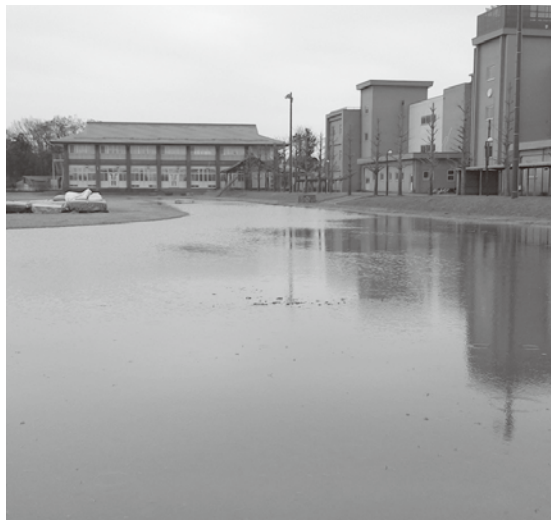
排水が全く機能していない米山中学校校庭
