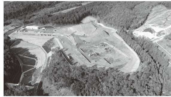
新クリーンセンター建設地
