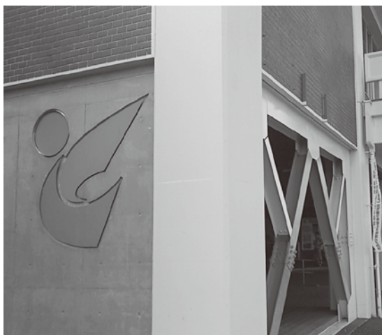
耐震補強された市役所庁舎
