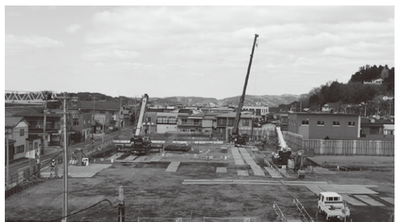
建設工事が進む米谷病院
