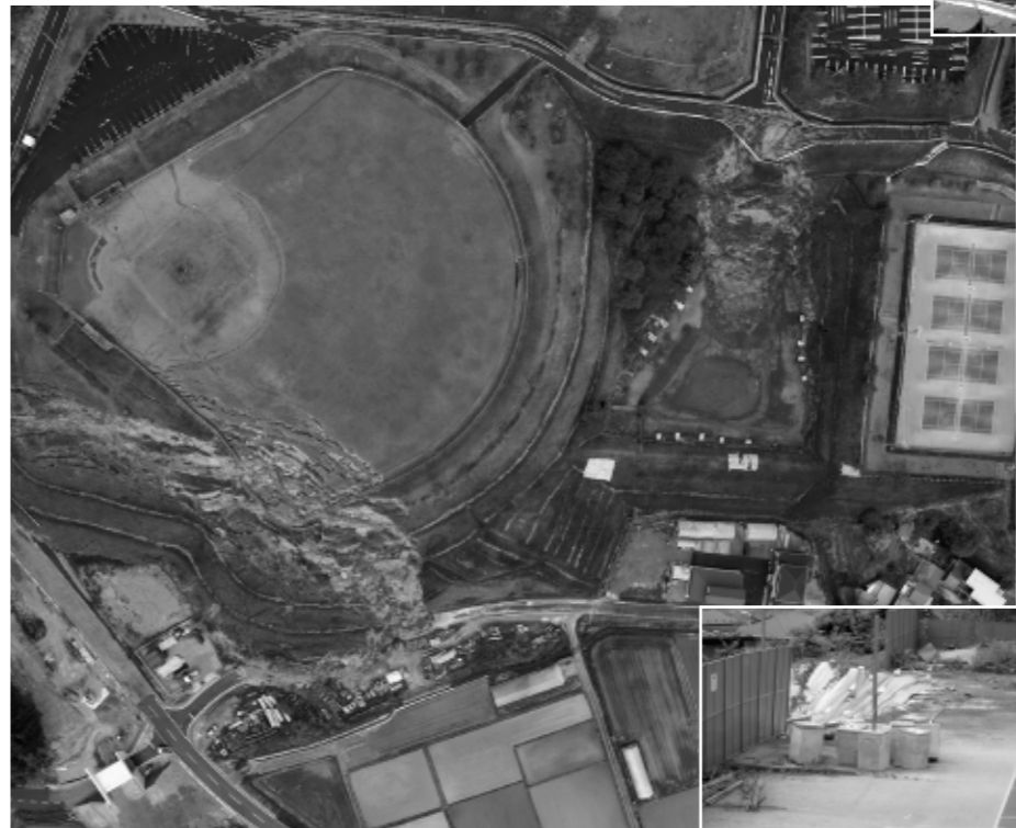
民家側に崩れたテニスコート
