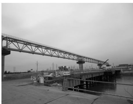
迫川水管橋復旧工事
