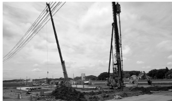
西部学校給食センター工事
