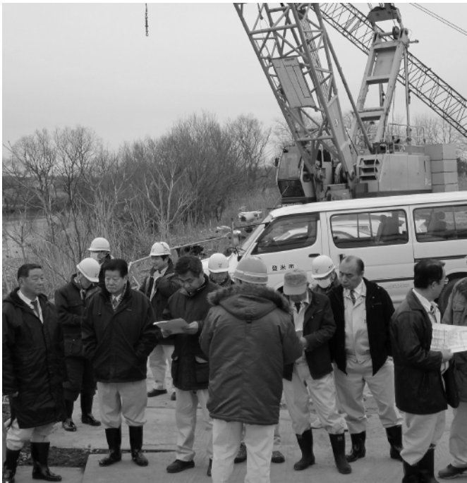
災害復旧現場調査
