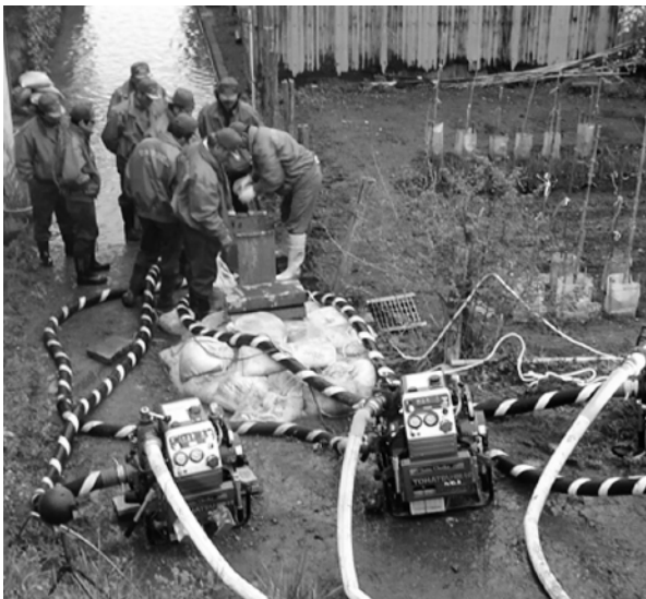
迫川から逆流した川水の排水作業 (佐沼五日町地内)
