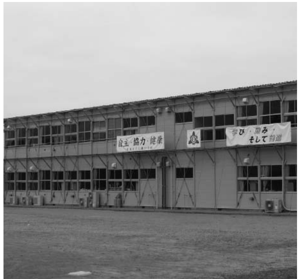
石越中学校仮設校舎
