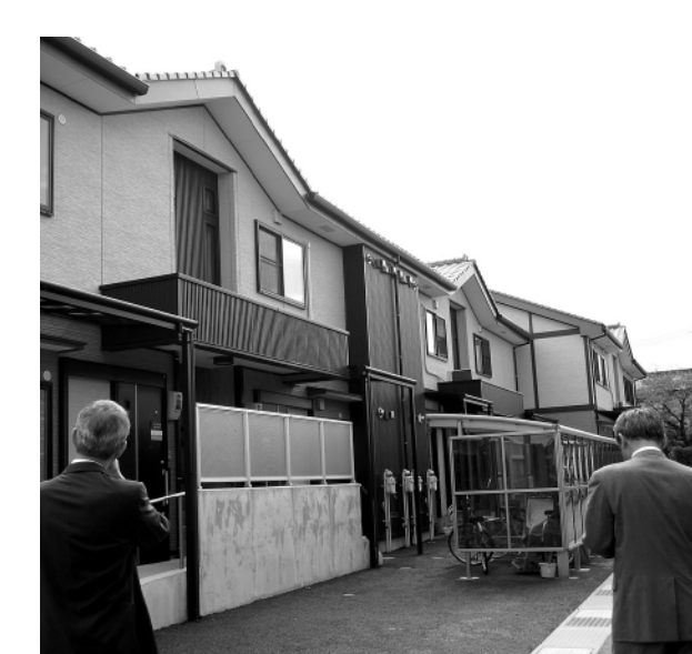
新潟県柏崎市の復興公営住宅
