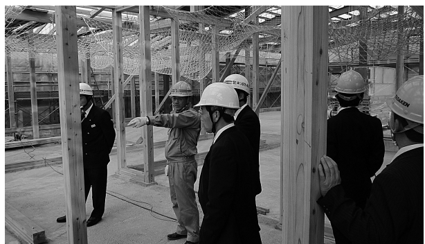
木造を取り入れた消防署西出張所
