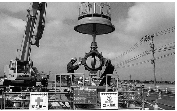
水道災害復旧工事
