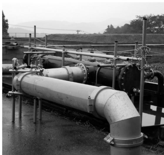
緊急用仮設水中ポンプ据付（保呂羽浄水場）
