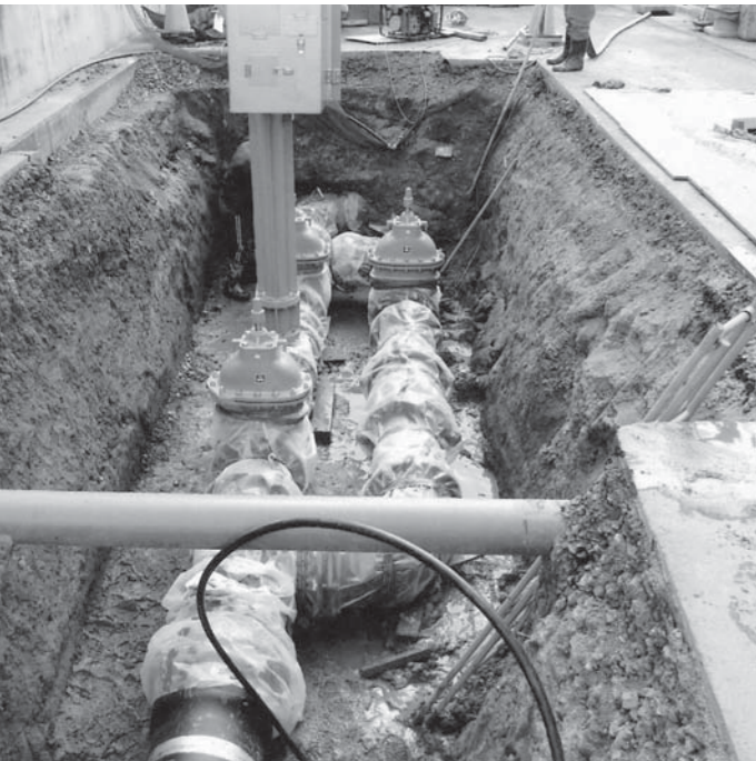
北方配水池緊急遮断弁設置工事
