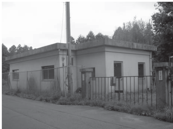
増圧ポンプの整備が待たれる旧新田第一増圧室
