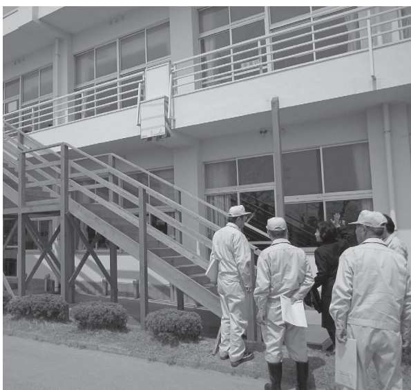
東郷小学校に設置された仮設階段
