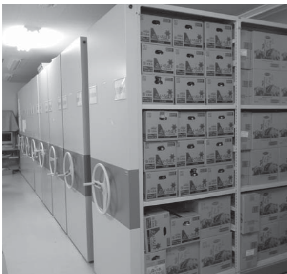
水や食料が備蓄されている石越防災センター
