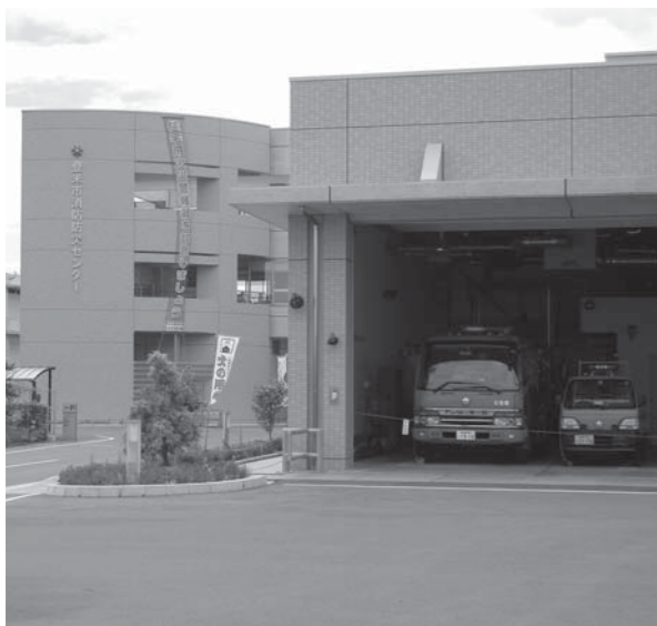
消防防災センター
