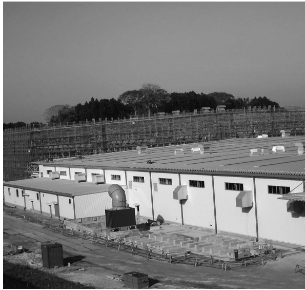
長沼工業団地に建設が進む「トヨタ東北」の新工場
