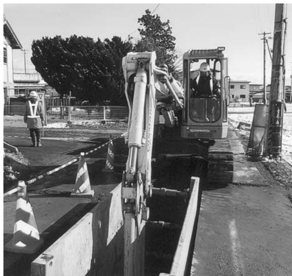
見直しが求められる下水道工事
