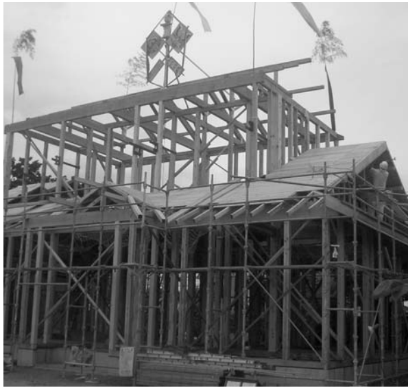
市内産木材を使った新築現場
