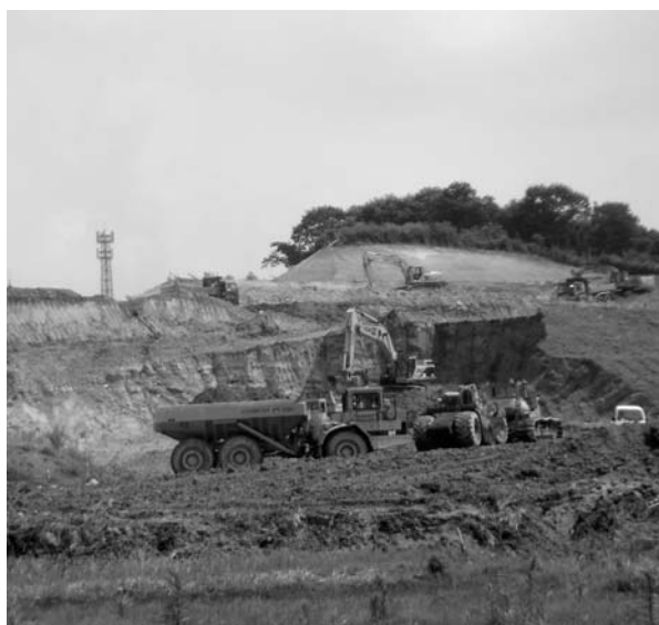
造成中の長沼工業団地
