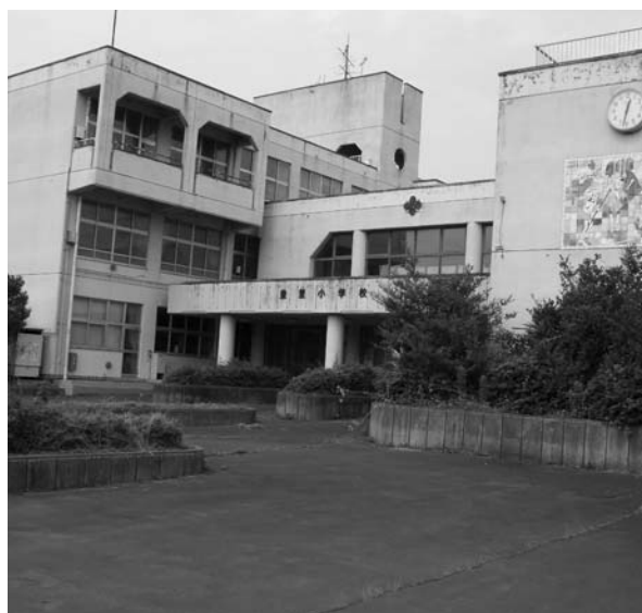
遊休施設になっている豊里小学校
