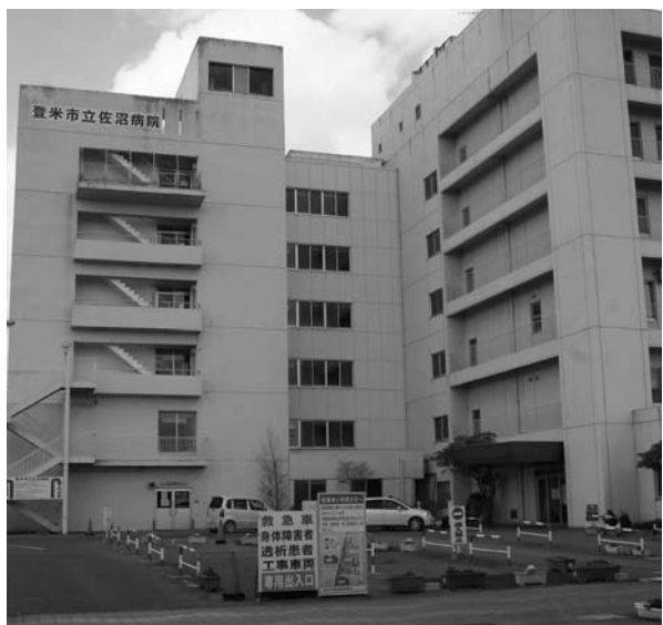
耐震工事が始まる佐沼病院
