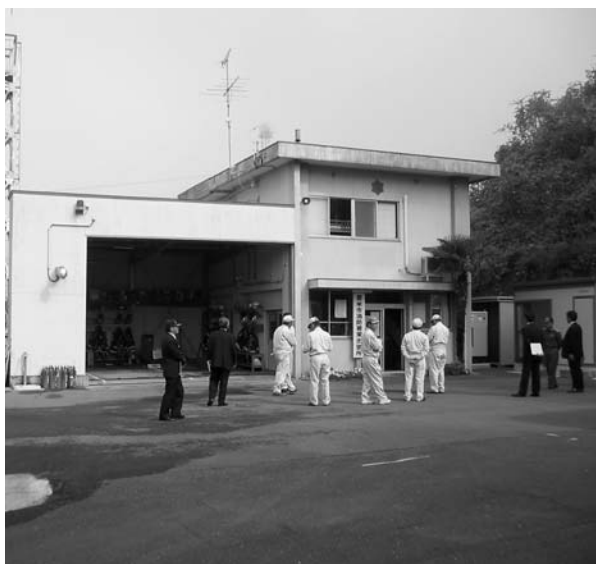
老朽化が進む東出張所（東和町米谷）
