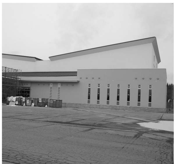
完成間近な豊里複合施設
