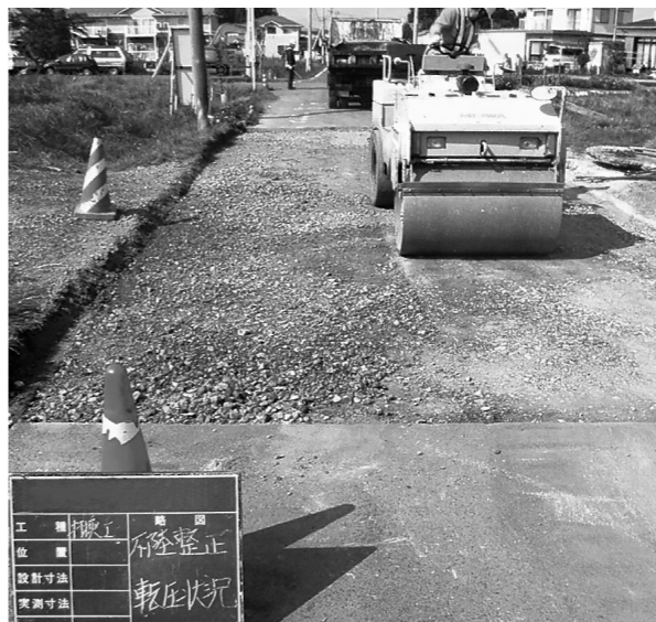
改良が進む生活道路
