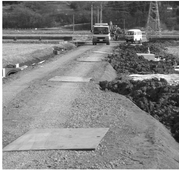
急ピッチで進む農道整備
