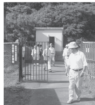
膜ろ過される米谷浄水場
