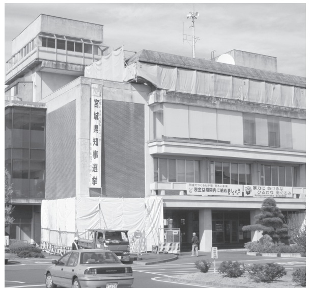
老朽化が進む旧庁舎
