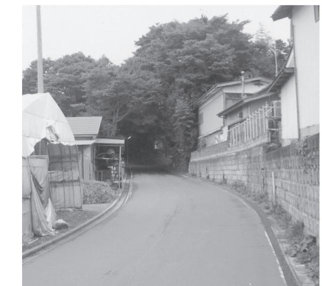
早急な改良整備が望まれる（米山町森腰地内）
