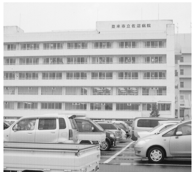
リハビリ棟を含め耐震補強が予定されている佐沼病院南館
