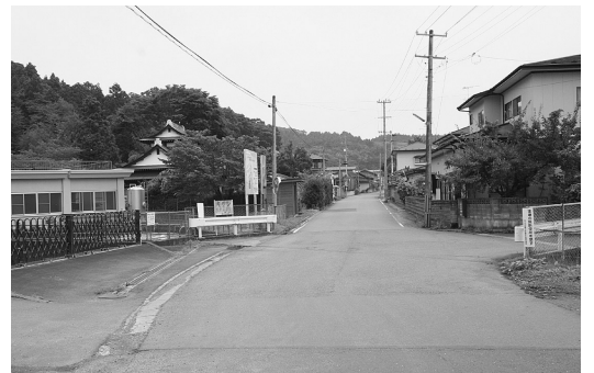
農業集落排水事業で整備される中田町大泉地区
