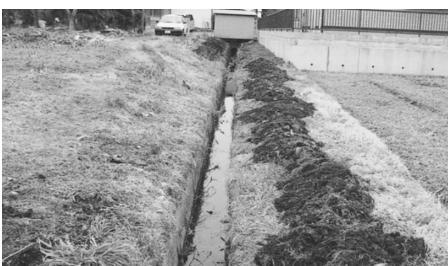
緊急雇用対策での側溝清掃
