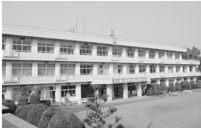
閉校となった善王寺小学校
