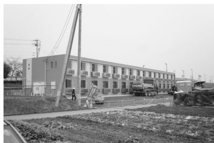
新築中の民間アパート
