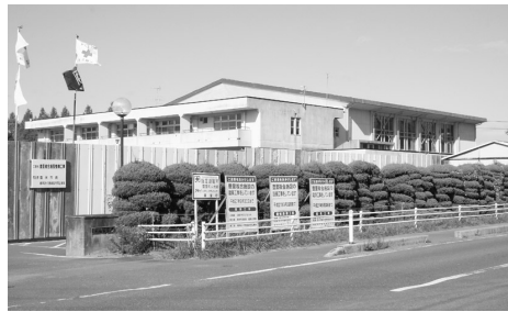
解体準備の進む豊里公民館
