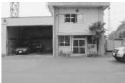
老朽化が著しい各消防出張所
