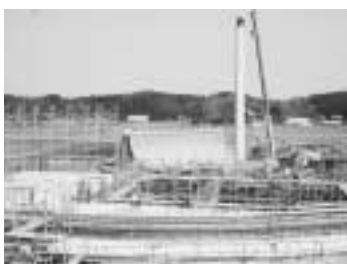
急ピッチで工事が進む市斎場
