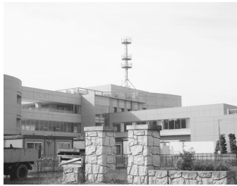
20年4月からスタートする消防防災センター
