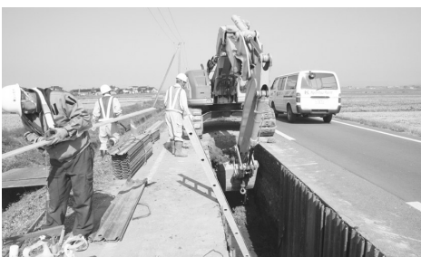
水道老朽管の交換工事（中田地内）
