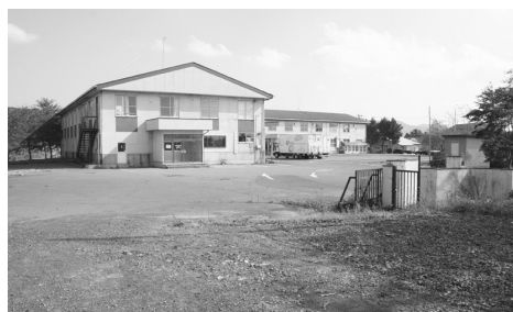
きたかみ園建設予定地 (旧水道事業所)
