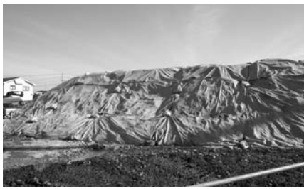
シートで被われているヒ素が検出された汚泥
