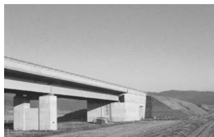
着々と工事が進む三陸道（豊里地内）
