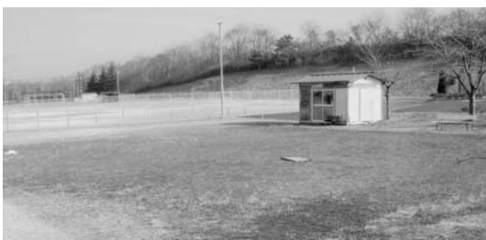
有料となるゲートボール場（新田総合運動場）
