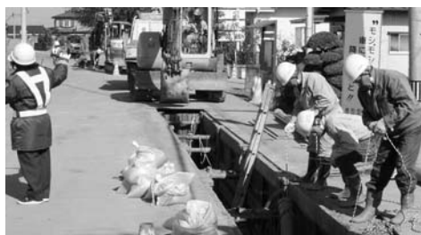
公共下水道工事（迫・江合地区）
