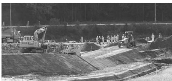
内水対策工事が進む南沢川（津山）
