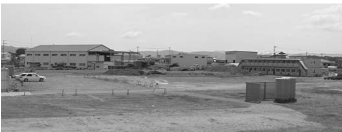
起工式が行われた登米市消防防災センター建設地
