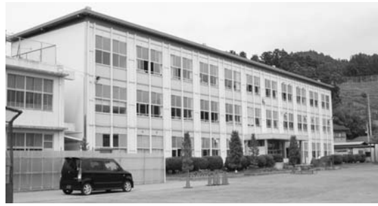
大規模改修される柳津小学校校舎
