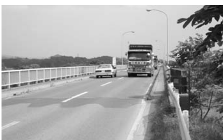
歩道の幅が狭く危険な豊里大橋
