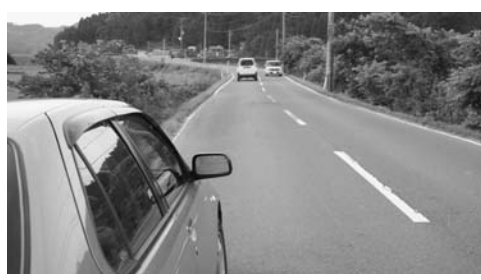
自歩道がなく狭隘な通学路(県道東和登米線・根廻地内)
