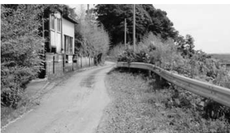
工事再開が待たれる生活道路（糠塚線）
