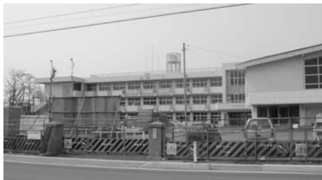
工事が始まった生涯学習センター
