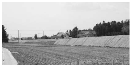
町域事業で工事中の沼畑・登米線
