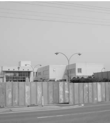
豊里中学校校舎増築工事
