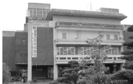
市庁舎の一元化は(迫本庁舎)
