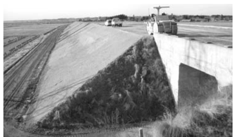
みやぎ県北高速幹線道一期工事(迫町北方地区)
