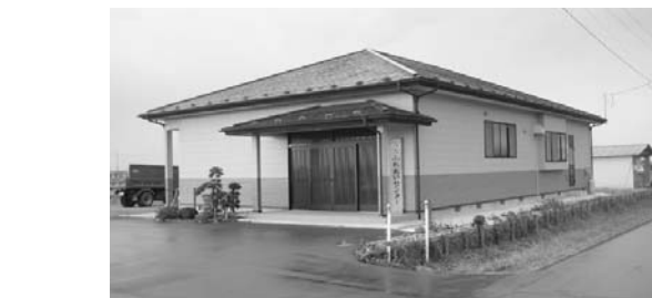
新築された集会所施設
