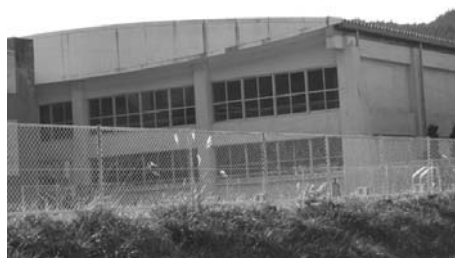
使用が禁止されている体育館
