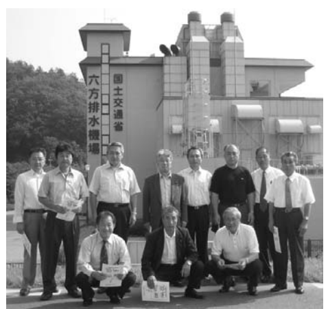
六方排水機場
