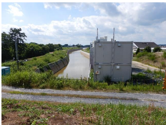
長沼川河川改修事業（排水機場）
