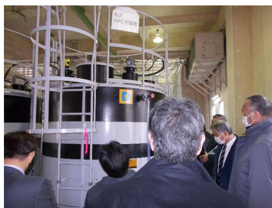
発電設備を撤去し、整備中の薬注棟内
