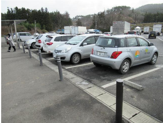
国管理側の駐車場には車止めがなく、車がぶつかりポールが曲がっている。車止めの設置を求めるべき
