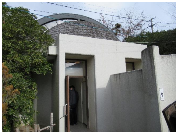
外トイレの入口に屋根がないため、冬季は凍結による転倒のリスクがあり、対策が必要である
