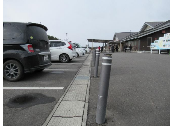
国管理側の駐車場には車止めがなく、車がぶつかりポールが曲がっている。車止めの設置を求めるべき
