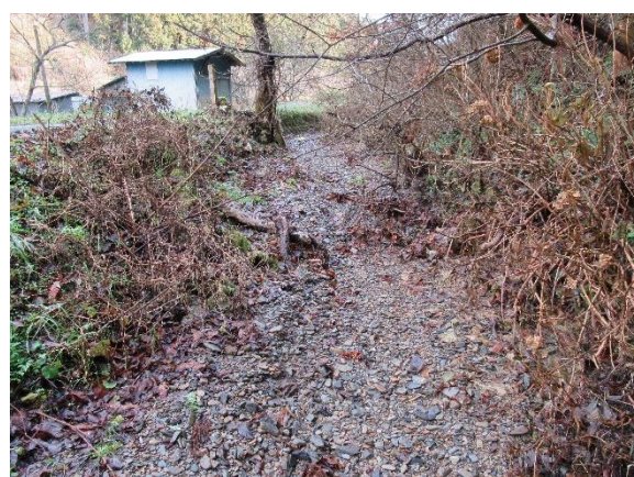
事業では、堆積土砂の撤去や支障木伐採を行う
