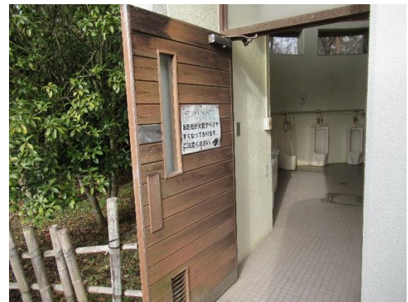
外トイレの入口に屋根がないため、冬季は凍結による転倒のリスクがあり、対策が必要である
