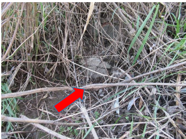
堆積した土砂により、船着場に降りる階段もわずかしか見えない。
