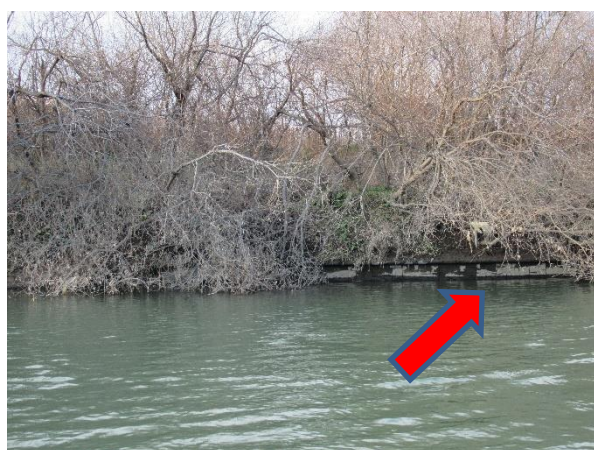
川側から船着場を見ると、その面影がわずかに残っている。
