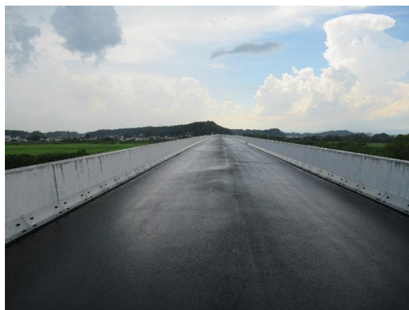
整備が進むみやぎ県北高速幹線道路（佐沼工区）
