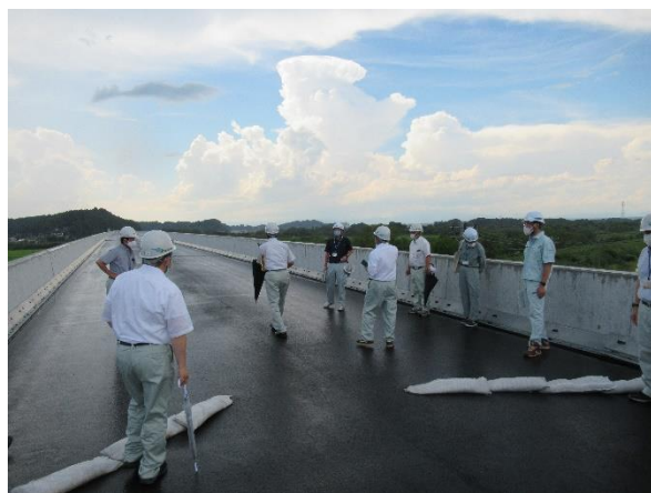
紫雲山大橋上で進捗状況について説明を受ける。
