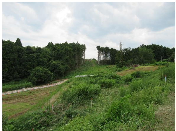
用地買収を終え、本年度から道路改良工事に着手
