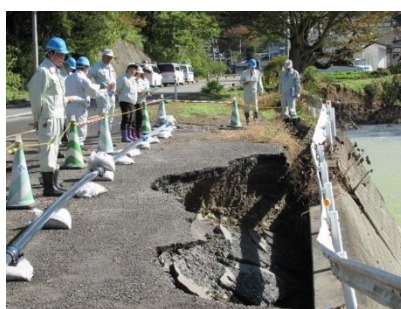
東和町米川字寺内地内の被害状況
