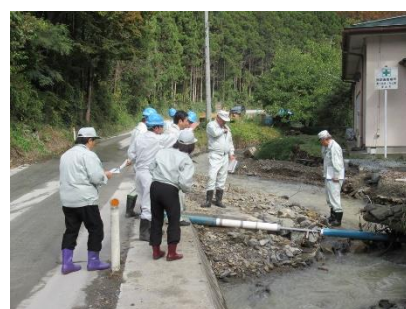
津山町柳津字大土地内の被害状況
