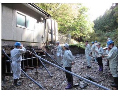
職員から大綱木浄水場の被害状況の説明を受ける
