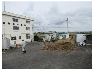
排水機場でも稲わら除去
