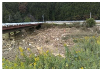
もくもくハウス裏仮橋に流木堆積
