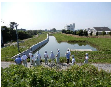
長沼川(河道掘削現場～放水路)
