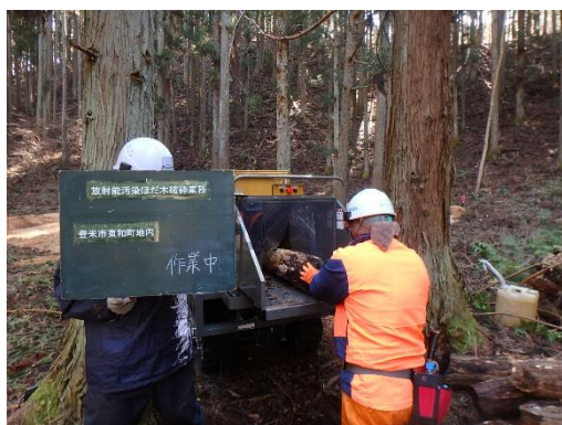
ほだ木破碎の様子 1
