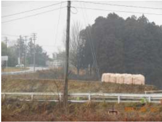
【1工区盛土工の状況】
