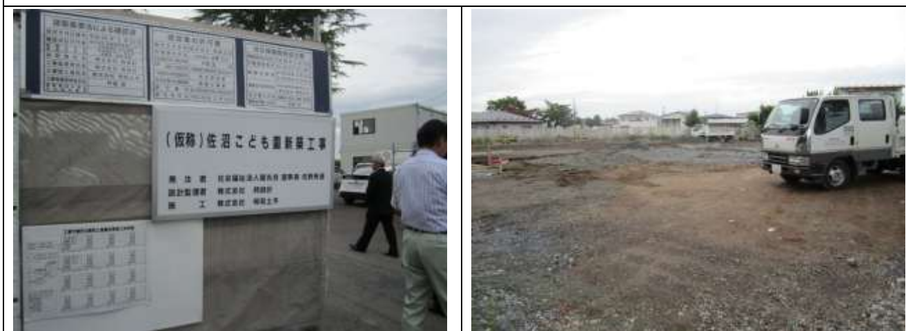
【佐沼こども園の工事現場】
