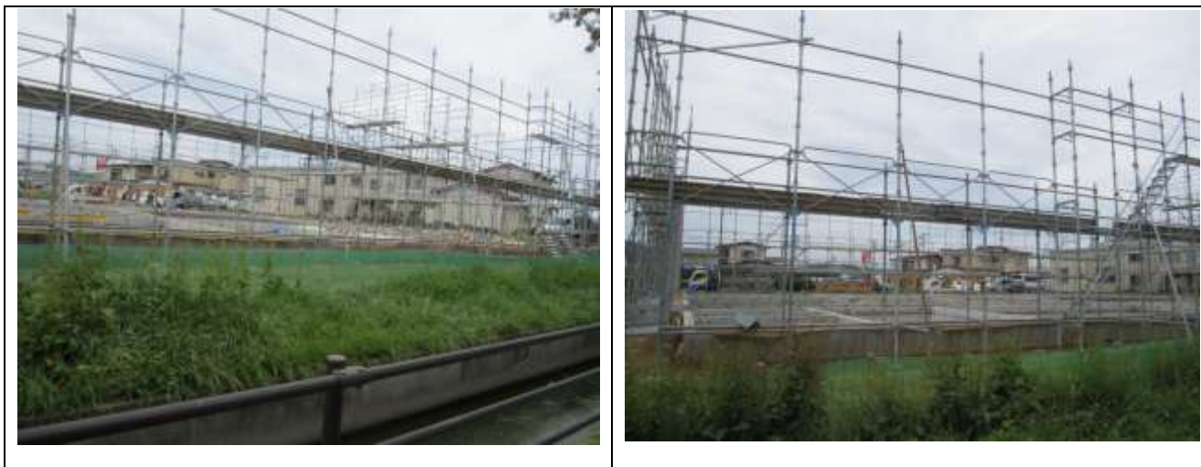
【登米こども園の建設現場】
