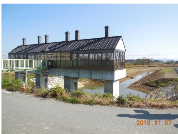
【H26 年度完成長沼川排水樋門】
