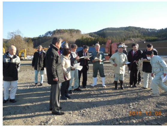
【(仮称) 登米PA・IC 工事現場④】
