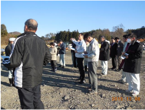
【(仮称) 登米PA・IC 工事現場③】
