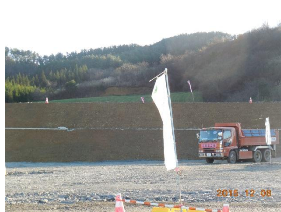
【（仮称）登米 P A ・ I C 工事現場②】
