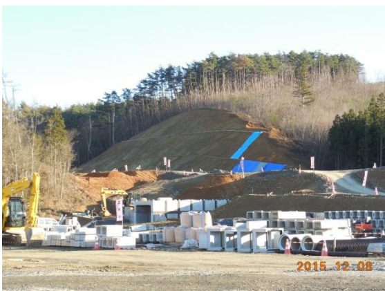
【（仮称）登米 P A ・ I C 工事現場①】
