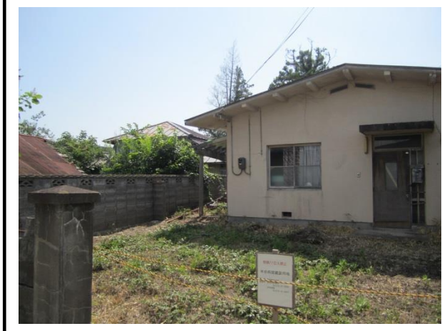
【隣接する旧米谷高等学校官舎も解体される】
