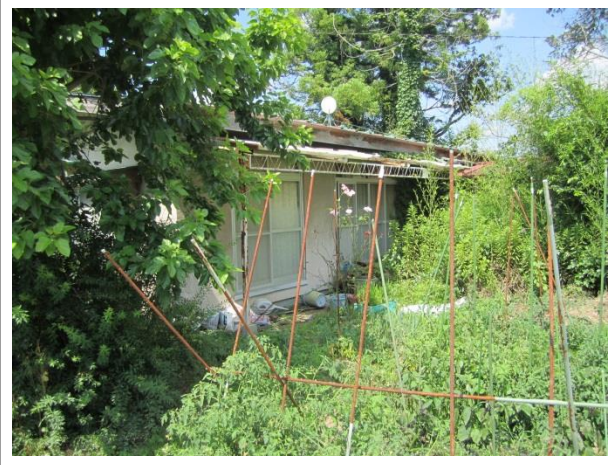
【新米谷病院建設にあたって解体される医師住宅】
