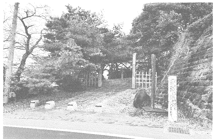
寺池城址公園（石垣と冠木門の現状）
