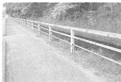
仮改修（単管設置）
