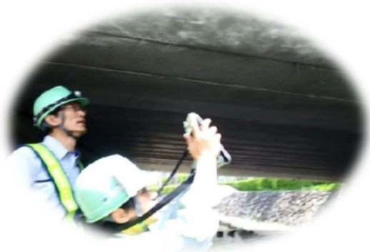
【タブレットによる点検】
