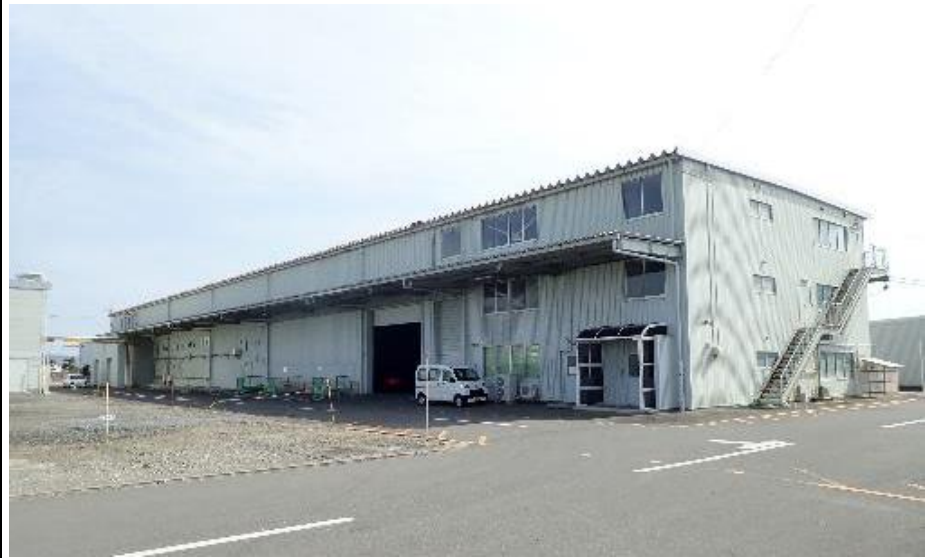
建物外観写真
