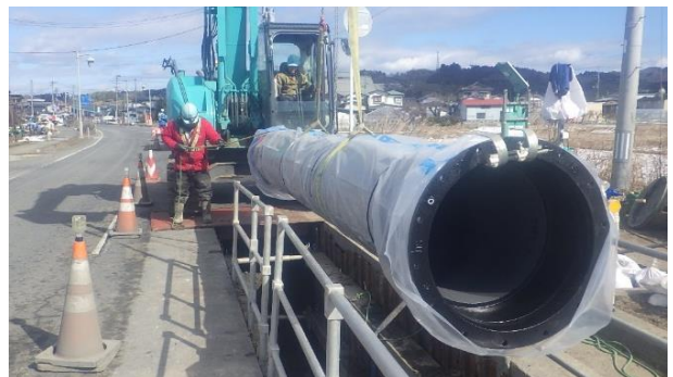
水道管布設状況
