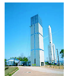
角田市スペースタワー コスモスハウス
